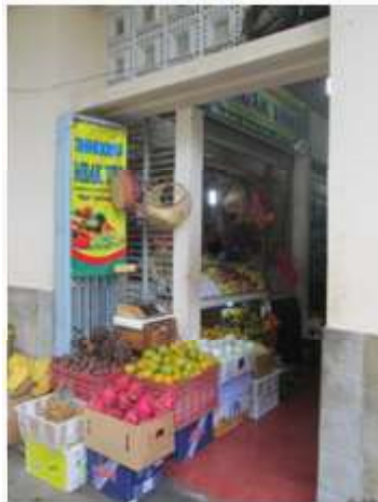
Gambar 26. Penempatan kolom struktur baru yang kurang tepat sehingga pedagang kesulitan mengelola display dagangannya.
